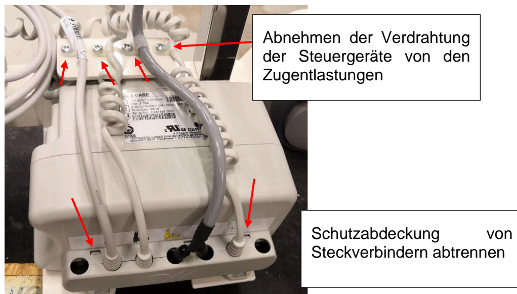
Abbildung 46. Abnehmen der Zugentlastungen und Schutzabdeckungen der Steuergeräte
