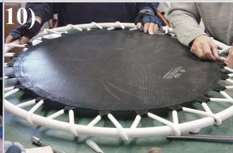
9+10) Wenn Sie das komplette Kabel gespannt haben, halten Sie beide Kabelenden fest. Nun öffnet eine zweite Person die Kabelschelle und befestigt beide Kabelenden mit dieser Schelle. Achten Sie darauf, dass beide Kabelenden 10 cm Überstand haben (siehe Markierung). Ziehen Sie nun beide Muttern fest an. Bitte das Kabel nicht durch zu festes Anziehen abdrücken.
